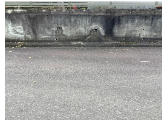
写真43 下流部擁壁水抜き穴からの出水跡あり
