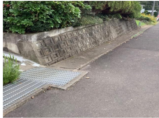
写真33 下流部擁壁と側溝の状況
