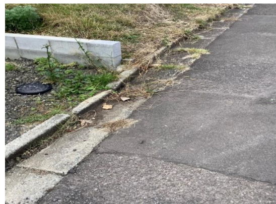
写真45 L字溝に沈下あり、隣接する地下埋の影響と思われる
