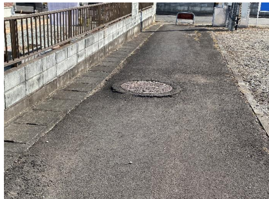
写真14 液状化によるマンホールの飛び出し
