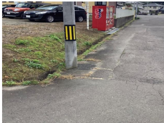
写真5 中流部道路とのり面の状況
