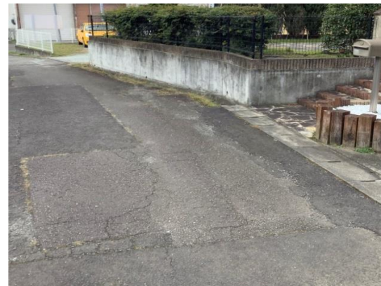
写真23 上流部道路と擁壁の状況
