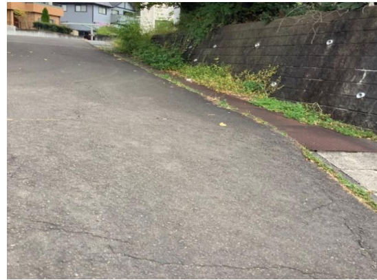
写真17 下流部道路と擁壁の状況
