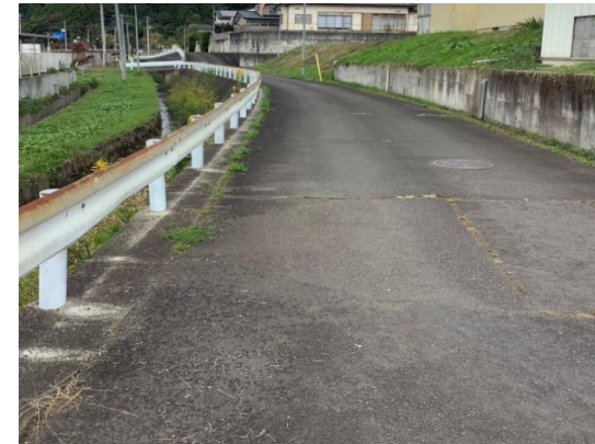
写真15 下流部道路の状況
