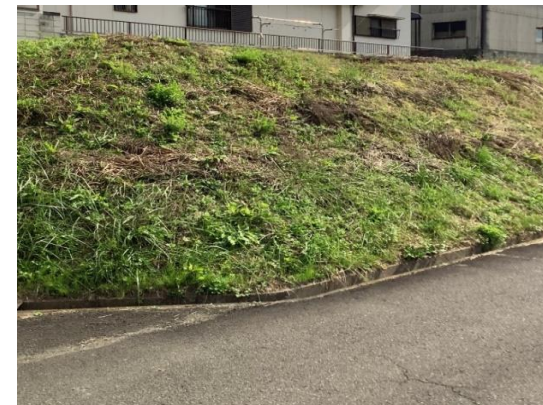
写真11 下流部のり面の状況
