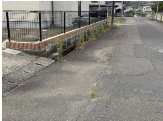
写真1 上流部道路の状況
