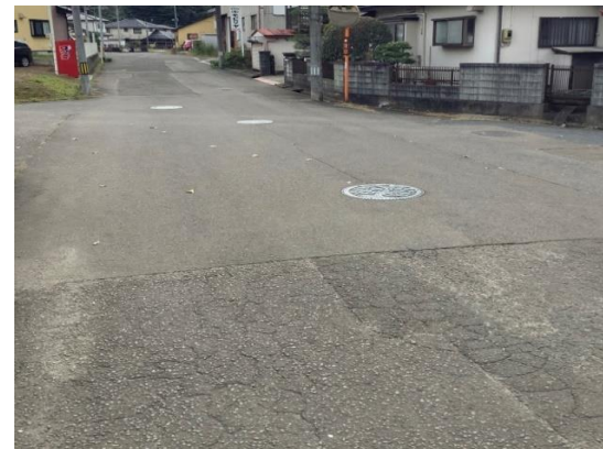
写真6 中流部道路の状況
