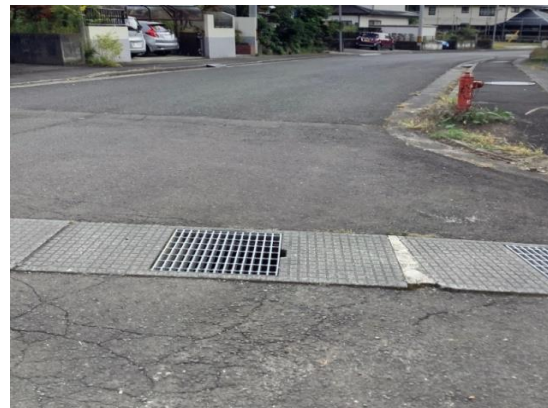
写真21 中流部道路の状況
