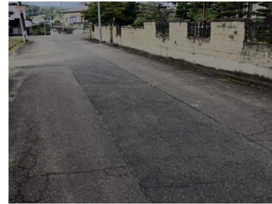
写真3 上流部道路と擁壁の状況
