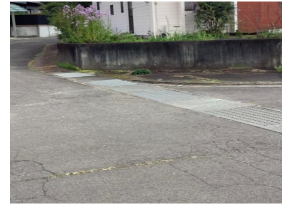
写真20 中流部道路と擁壁の状況
