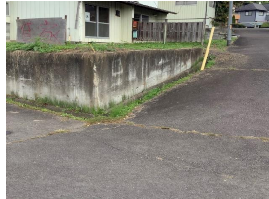
写真14 下流部道路と擁壁の状況
