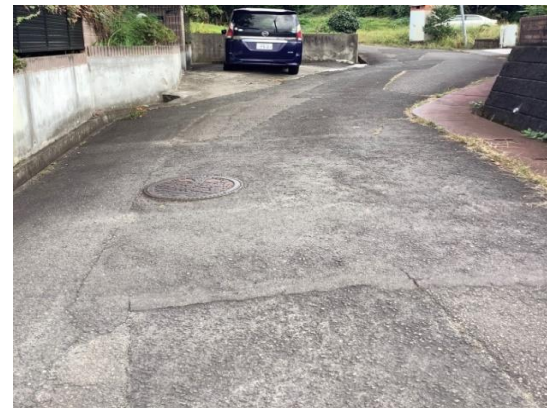
写真22 上流部道路の状況
