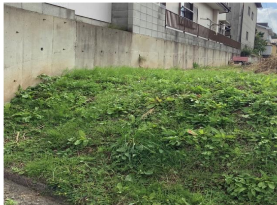
写真9 下流部擁壁とのり面の状況
