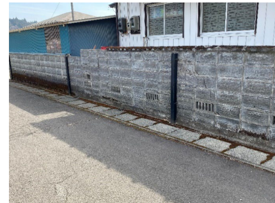
写真23 のり面上部の宅地ブロック塀に残る斜亀裂
