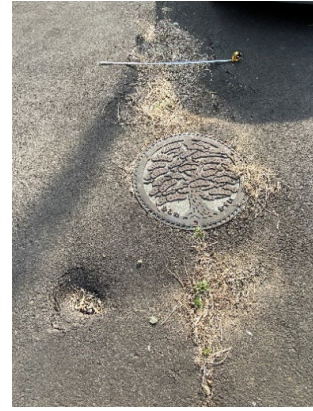
写真18 マンホール周囲の陥没
