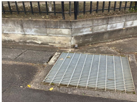
写真5 上流部擁壁に小規模の亀裂あり
