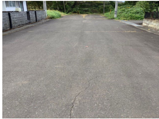
写真17 下流部路面に小規模の亀裂あり
