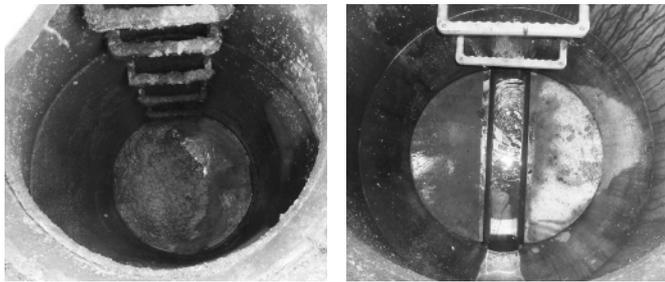
▲油が固着し、下水管を閉塞している状態 ▲清掃後の下水道マンホール
