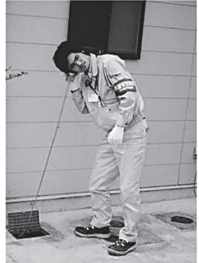
【漏水調査の様子】
