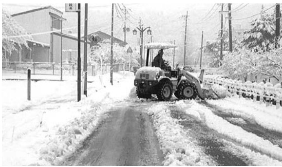
除雪作業の様子
