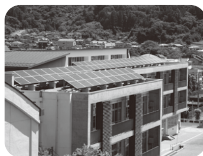
村田小学校屋上太陽光パネル
