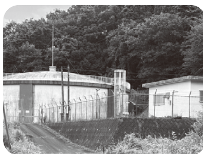
村田町上水道西原高区配水池
