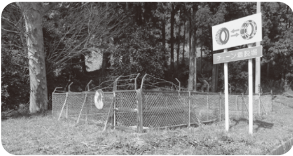
東足立地区防火水槽
