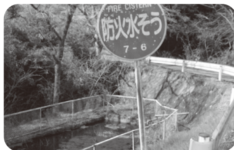
沢水を活用した防火水槽
