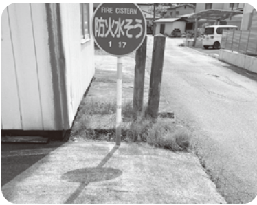
有蓋防火水槽
