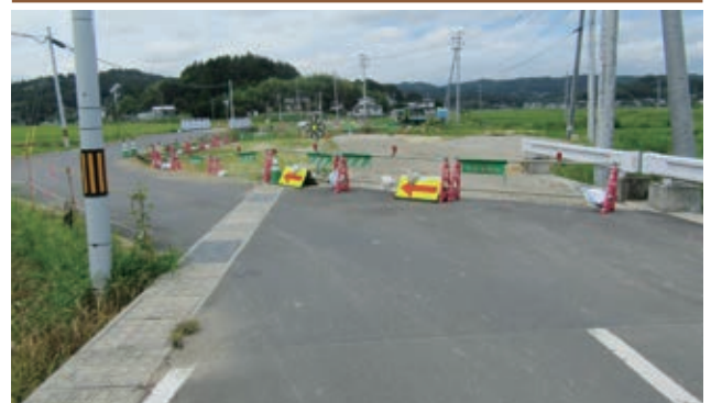
改良中 現地写真（仮橋設置・迂回路状況）
