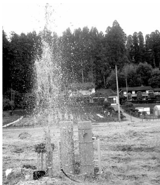
ある時は隠し、見つければ「現場アタリ」のバンソウコで手当てし……想定外だと開き直って、止めようもなく何度も噴き上げる我らが竹の内の「産廃ガス汚水間歇泉」 原因を究明しようにもボーリング・コアは捨ててしまったしなあ! (平成23年11月28日)
