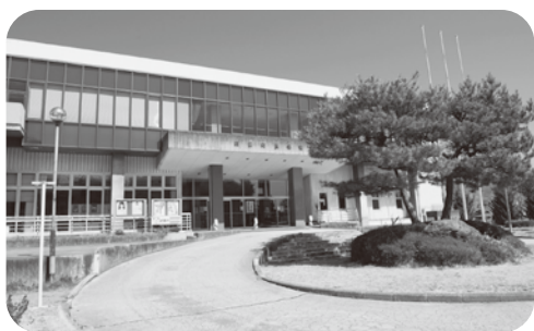
改修予定の村田町民体育館
