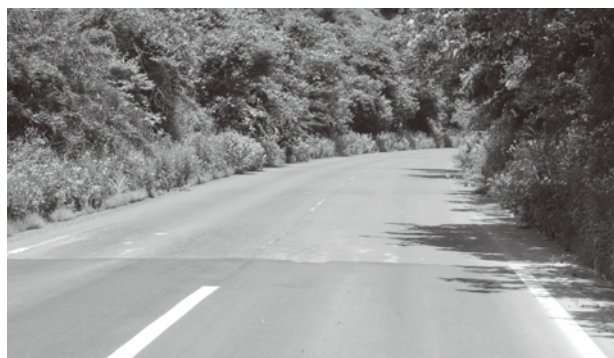
町道西原蛇沢線 改良舗装
