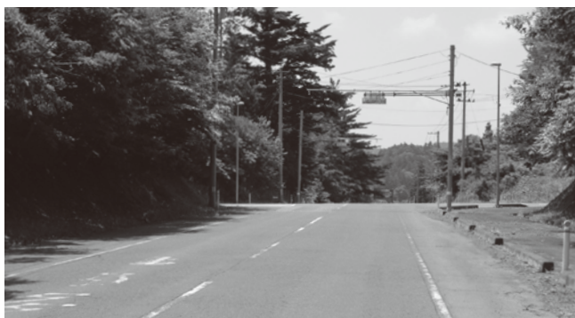
町道薄木沼田線 改良舗装
