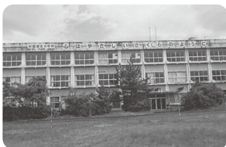
解体前の旧第5小学校
