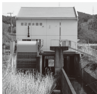
沼辺排水機場
