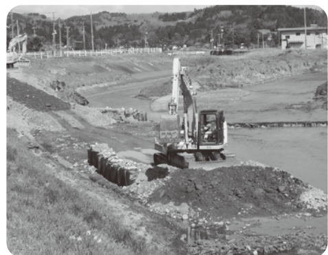
盛田周辺での荒川の堆積土砂撤去作業
