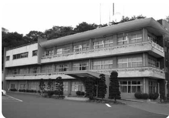
老朽化のため建設が望まれている村田町役場庁舎
