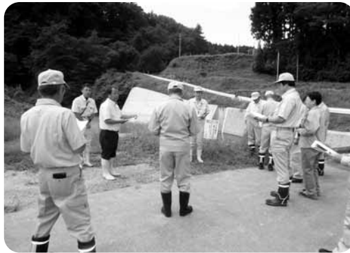
西足立岩倉の災害復旧現場
