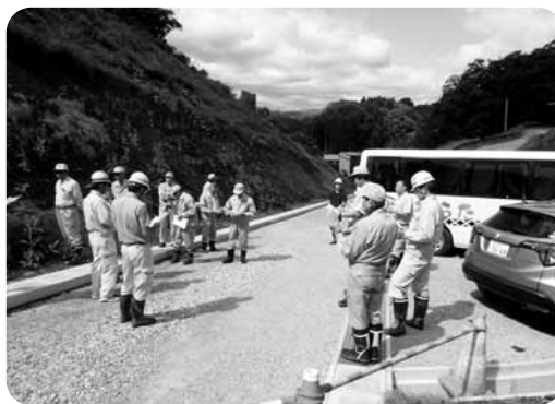
工事中の町道松山寺線
